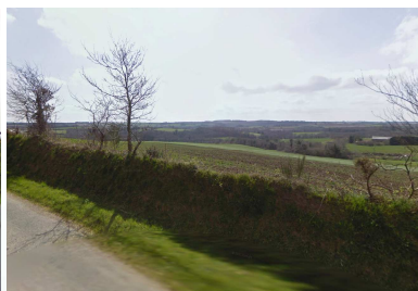
C – Talus dégarni, Lannéanou.
